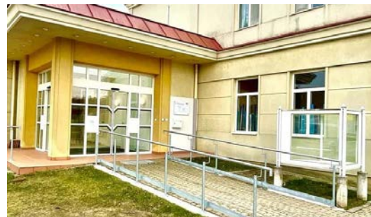
Kassenordination barrierefrei umgebaut
